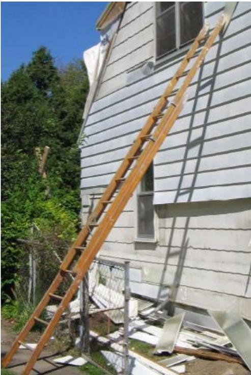
Foto del informe MIFACE [05MI163](#). La escalera no tiene pies de seguridad, no estaba asegurada, está apoyada contra una puerta móvil y no sigue la regla 4:1.
